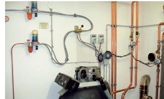
Abb. 1: Feldanlage mit Messtechnik
